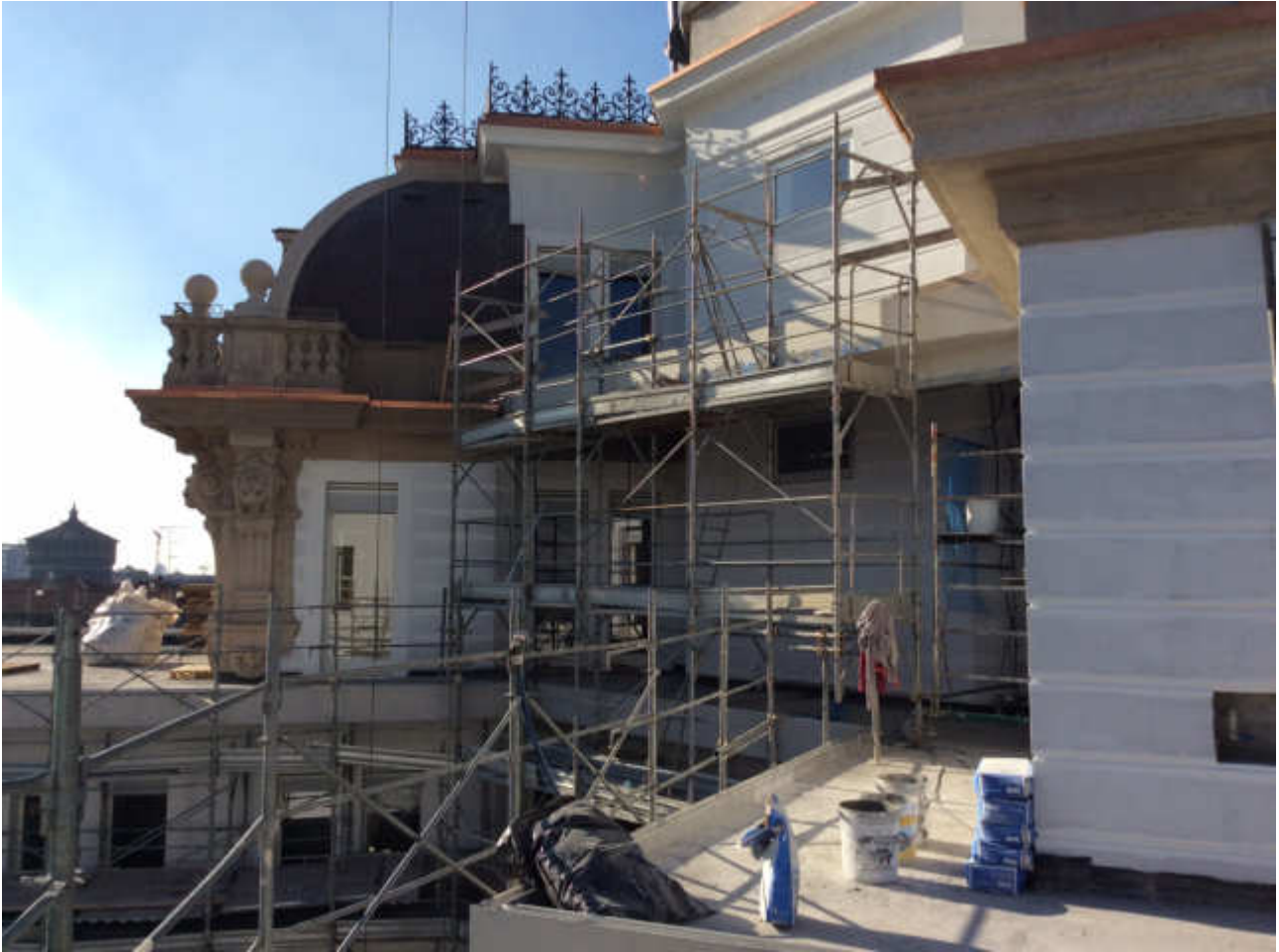
Durante i lavori
