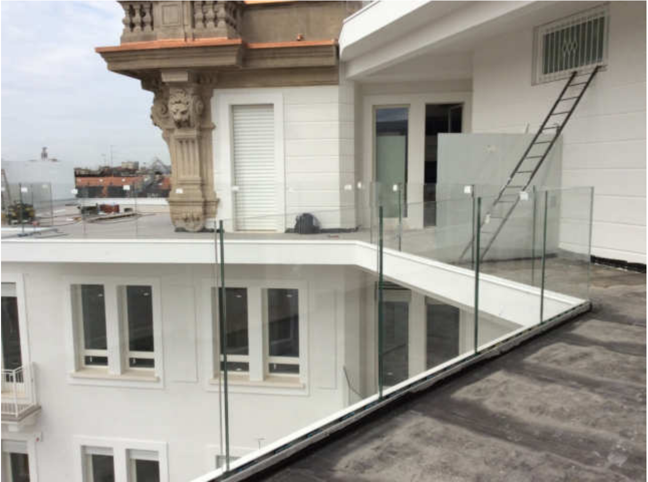
Ultime fasi dei lavori
